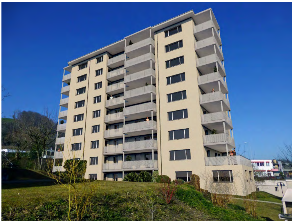
Grisigenstrasse 1 nach Abschluss der Sanierungsarbeiten
